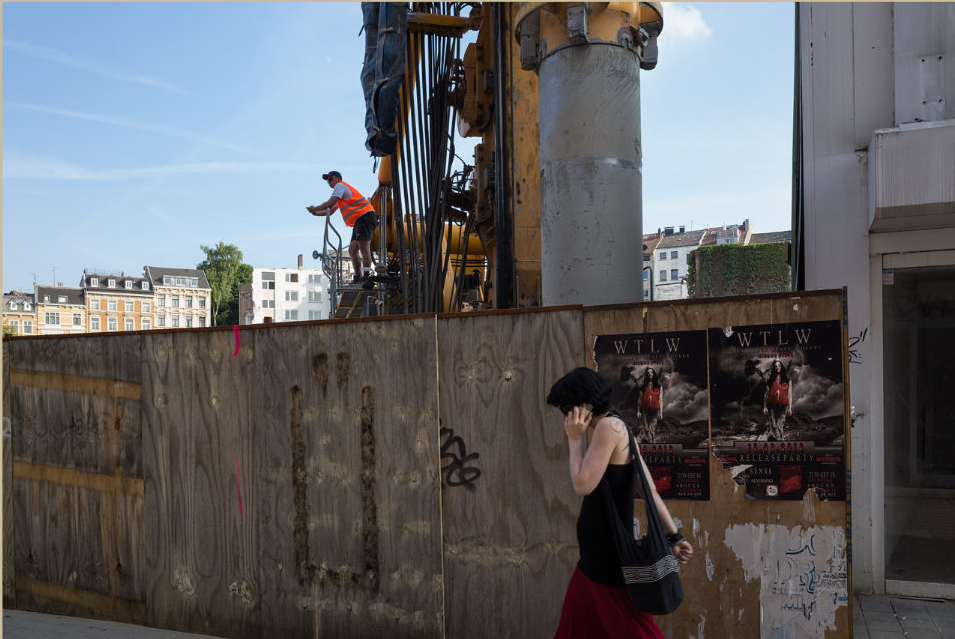
Picture of the week 2013 (32), Baustelle Kaiserplatz, Aachen Juli 2013
