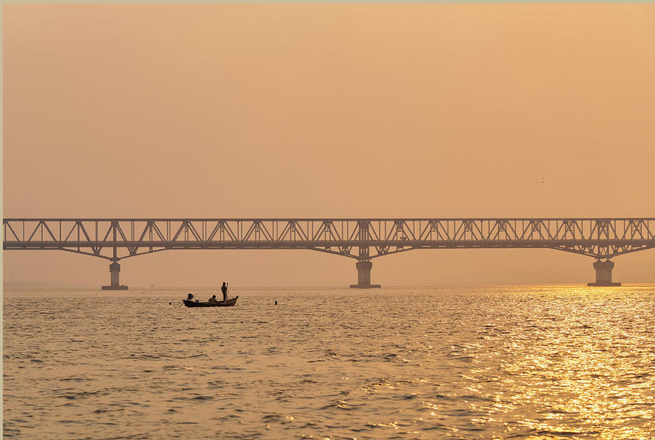
Picture of the week 2019 (10), Brücke über den Than Lwin Fluss, Mawlamyine, Süd-Myanmar, März 2019
