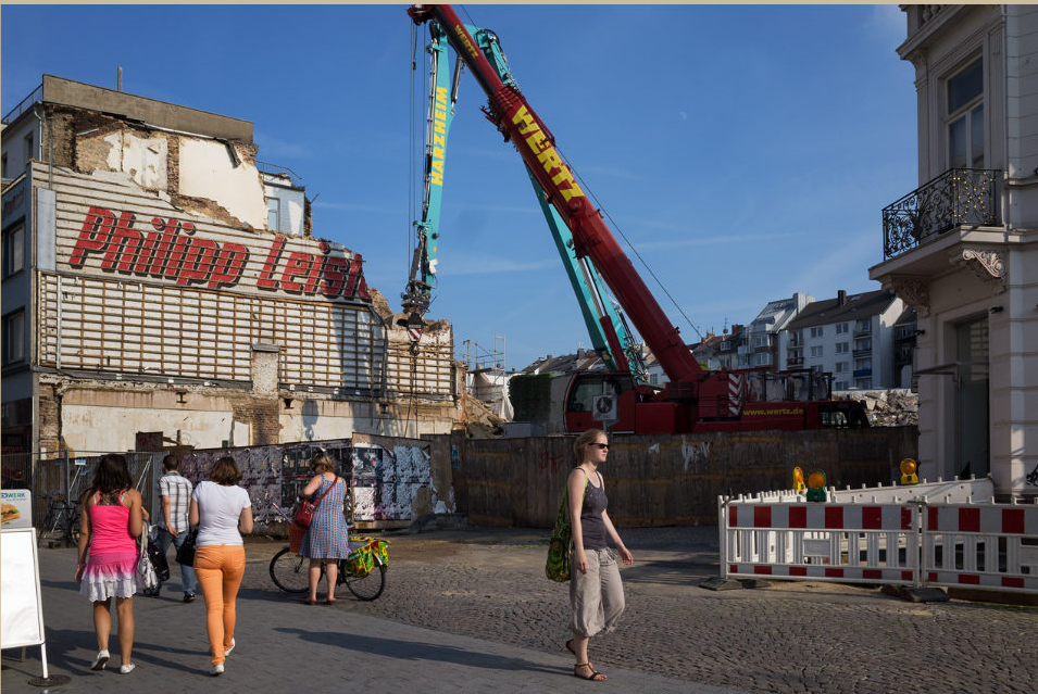
Picture of the week 2013 (30), Baustelle Kaiserplatz, Aachen Juli 2013
